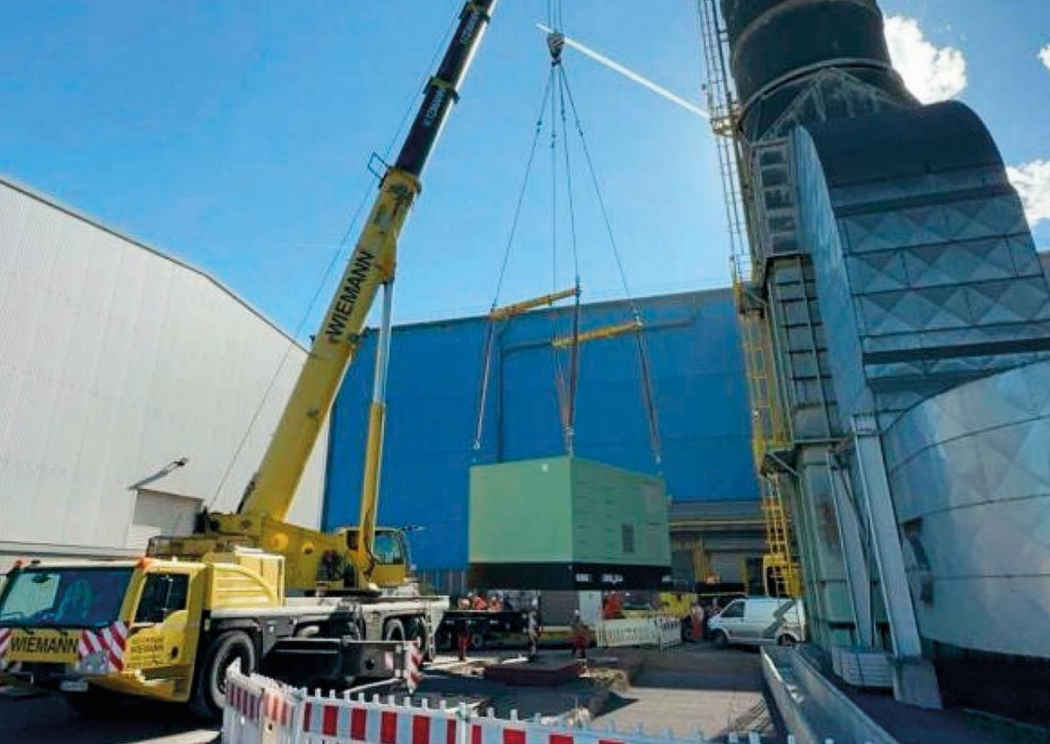
Wegen begrenztem Platz entschied sich Reitz Retrofit für ein innovatives Konzept mit drei separaten Elektroräumen. Jeder Raum enthielt einen 6KV/690V-Transformator (2 MVA) sowie einen Niederspannungsraum für Steuerungsschränke und Frequenzumrichter. Ein effizientes Kühlsystem, basierend auf einer CFD-Analyse, hält staubhaltige Luft aus den Elektroräumen fern.
