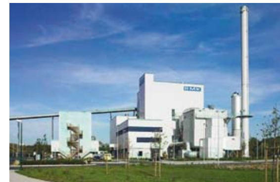
Biomassekraftwerk Lünen, komplett ausgestattet mit REITZ drehzahlgeregelten Primärluft-, Sekundärluft- und Rauchgaszirkulations- und Saugzugventilatoren. Foto: REMONDIS, Lünen
