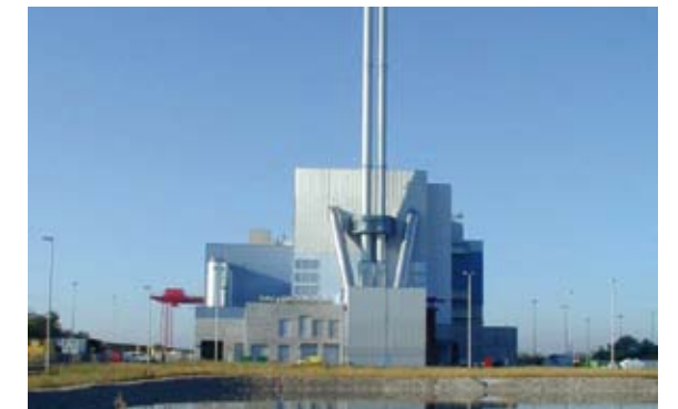
Biomassekraftwerk Dürnrohr, ausgestattet mit REITZ Ventilatoren. Foto: AE&E Inova, Köln
