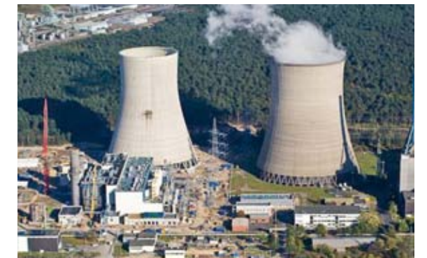
Erdgaskraftwerk Lingen, ausgestattet mit REITZ Ventilatoren. Foto: RWE Power
