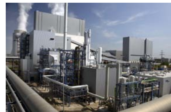
Oxyfuel Pilotprojekt Schwarze Pumpe von Vattenfall. Ausgestattet mit REITZ Ventilatoren entsteht das erste CO 2 -freie Braunkohlekraftwerk der Welt. Foto: Vattenfall, Berlin
