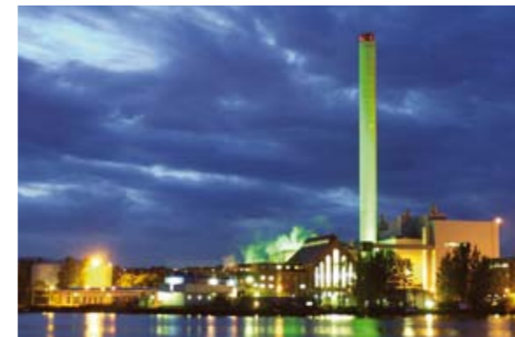
Kraftwerk Flensburg, ausgestattet mit REITZ Ventilatoren Foto: Stadtwerke Flensburg
