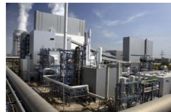
Oxyfuel Pilotprojekt Schwarze Pumpe von Vattenfall. Ausgestattet mit REITZ Ventilatoren entsteht das erste CO 2 -freie Braunkohlekraftwerk der Welt. Foto: Vattenfall, Berlin
